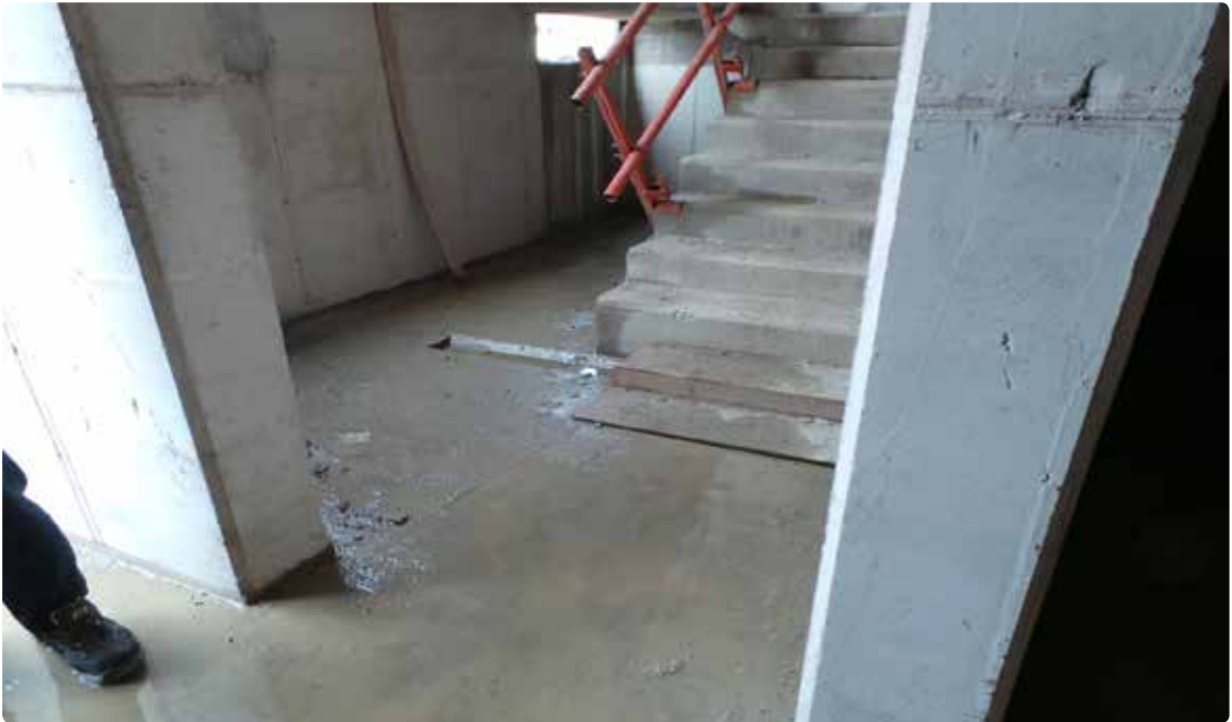
[사진1] 재해자가 최초 목격된 지하1층 계단실
