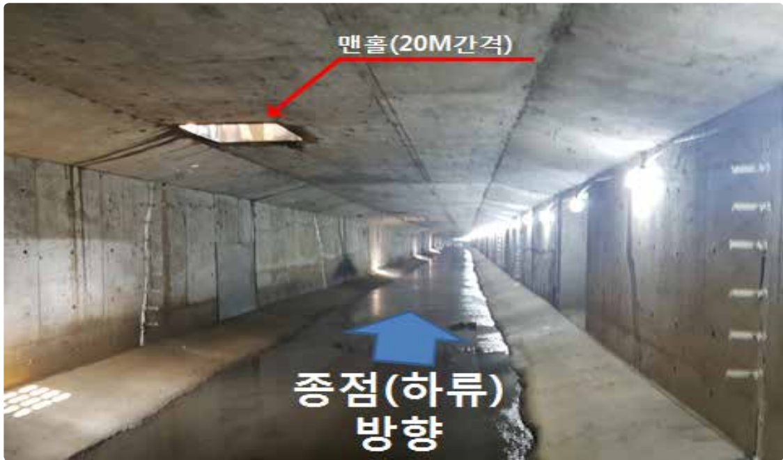
[사진1] 재해발생 현장 내부 전경
